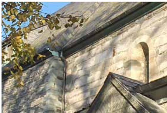
Skipets sørvegg «bommer» på tårnets sørvegg med 40-50 cm. Dette førte også til at takvinkelen over tårnet måtte endres. (På 1800-tallet hadde kirken samme takvinkel, men da stakk taket lenger ned på tårnets sørvegg. Resultatet var en skeiv gavlspiss i vestfasaden).
