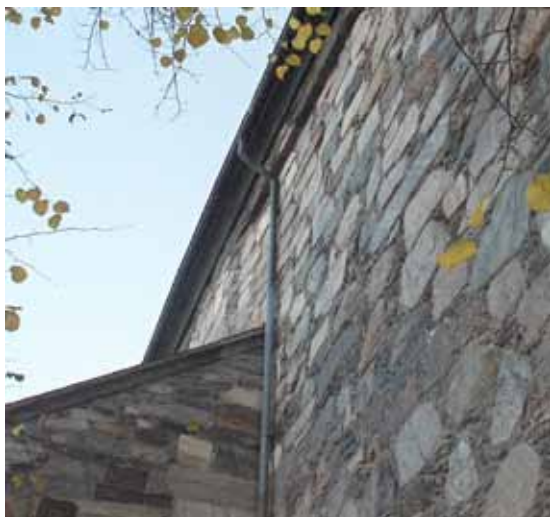
Skipets nordvegg er «spisset» slik at den treffer tårnet. Dermed beholdes samme takvinkel på nordsiden.
