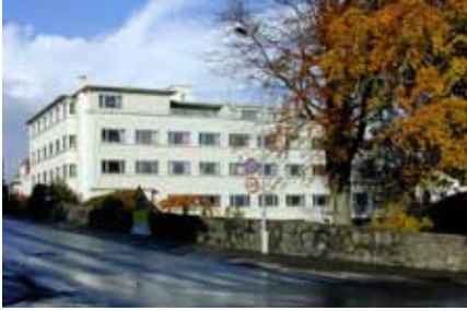
Wesselsgate 51. Solvang omsorgboliger for eldre, på tomten sto tidligere Charles Racines sveitservilla.
