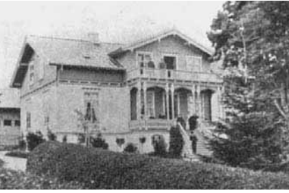
Bjergsted med hovedhuset som brant ned under krigen.
