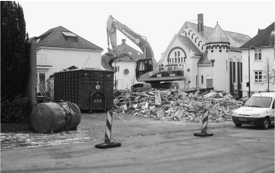
Løkkeveien 54, etter rivingen, (Bethel i bakgrunnen)
