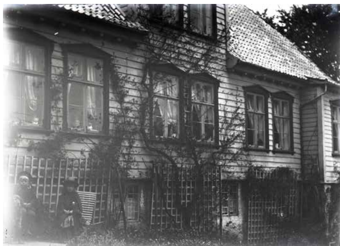
«Sølyst» bygget av Eiler Hagerup Schjøtz i 1822. Foto: Kulturhistorisk avdeling/Museum Stavanger
