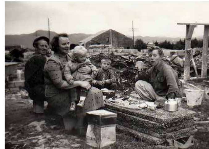
Boligbyggingen etter krigen kom for alvor i gang omkring 1955. Mange var «selvbyggere» og hele familien stilte opp når grunnen skulle graves ut, og slekt og venner deltok på dugnad når grunnmuren skulle støpes. Her er det familien Thoresen som nyter en matpause. De befinner seg på «Blidensol», navnet kommer av et hus ble flyttet fra Blidensolstredet i Gamle Stavanger og hit opp. Foto ved Svein Audun Thoresen
