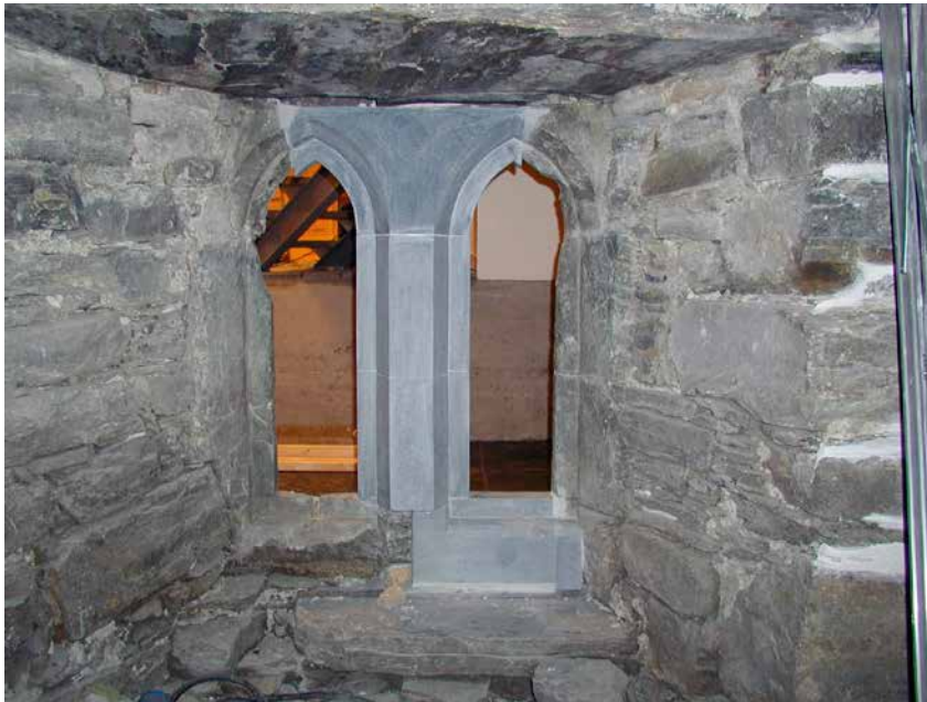
Innsetting av manglende stein i ny klebersteinsom ble laget utfra oppmålingstegnningene. Foto: Ann Meeks, Arkeologisk museum – Universitetet i Stavanger.
