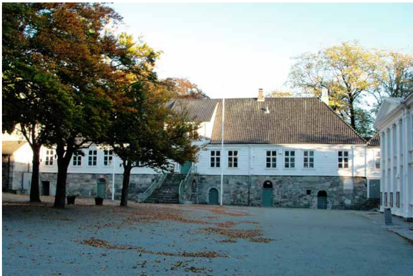
Figur 1. Kongsgårdsbygningen med den gotiske førsteetasjen i stein og den barokke andreetasjen i tre. Bispekapellet som er bygget i andre halvdel av 1200-tallet ligger vegg i vegg til venstre for kongsgårdsbygningen, mens deler av skolebygningen fra andre halvdel av 1800-tallet kan skimtes i høyre billedkant. I 2002 ble det funnet spor av en trebygning fra 1100-tallet like inntil skolebygningen. Foto: Sveinung Bang-Andersen
