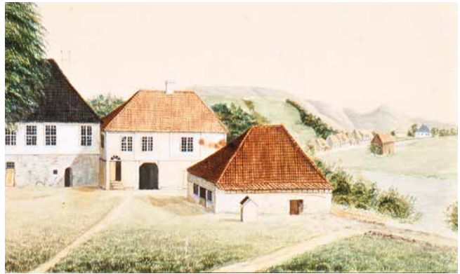
Figur 5. Søndre del av Kongsgård 1845. Ildhuset, som ble revet i 1850, er en av flere bygninger på Kongsgård som har hatt underetasje i mur. Vi vet imidlertid ikke om disse murene er bygget i middelalderen, eller senere. (Kilde Riksarkivet)
