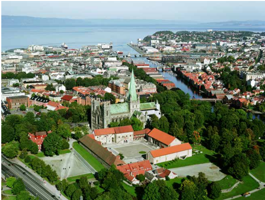
Nidarosdomen og Erkebispegarden i Trondheim sett frå lufta mot nord. Dette er det best bevarte anlegget av sitt slag i Norden, og viser korleis slike monumentale anlegg dominerte bylandskapet. Foto: Privat.
