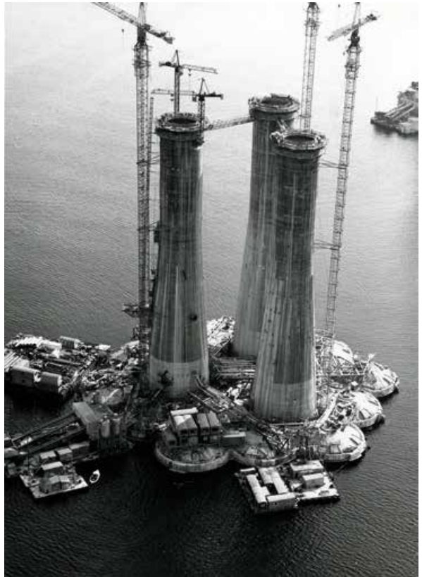
Betongdelen og skiftene på Statfjord A i full høyde. Foto: Norsk Oljemuseum
