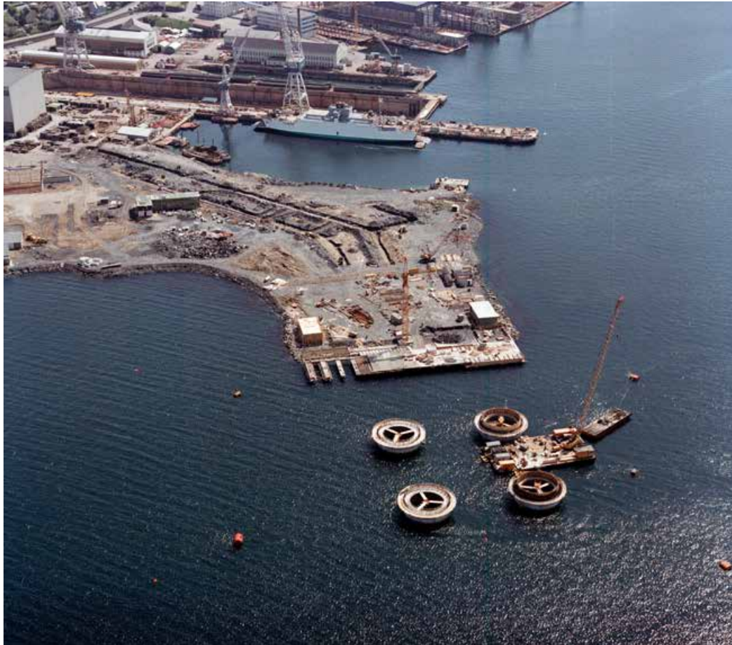
Kaiområdet og betongsøyler klar til å motta de første leveransene til Statfjord B. (Foto Leif Berge/Equinor)
