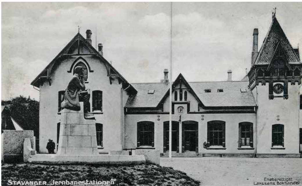
Den gamle stasjonsbygningen i Stavanger, med statuen av Asbjørn Kloster i forgrunnen. Gammelt postkort. (Fotograf: Tønnes Sandstøl – Stavanger Byarkiv)
