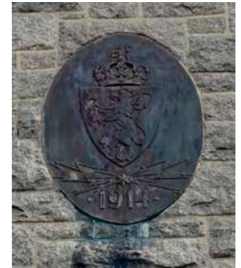
Senderstasjon og transformatorhus i hugget granitt stod ferdig i 1914, men kunne først tas i bruk i 1919 på grunn av første verdenskrig. Foto: Lars Olsen Neby.
