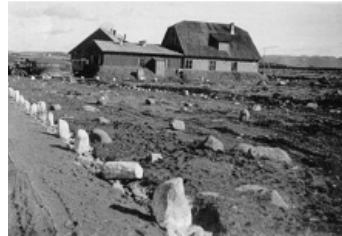
På Forus og Sola satte tyskerne i gang store anleggsarbeider like etter invasjonen i april 1940. Her er en tysk sove- og oppholdsbrakke kamouflert som gårdstun med løe og bolighus. (Foto fra samlingen til Flyhistorisk museum, Sola, tatt av tyske soldater våren 1940. Fotonettverk Rogaland)
