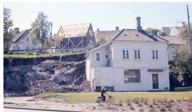
Skomakeren i Nedre Kleivegata 12 ventet i 1975 på at huset skulle gi rom til det nye rådhuset og trappene i Kleivå. Foto: Ommund Lunde/Byarkivet.
