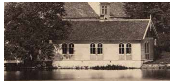
Sangsalen med spir og nygotiske vinduer, slik arkitekt von der Lippe formga den. Foto: Billedsamlingen til Universitetet i Bergen
