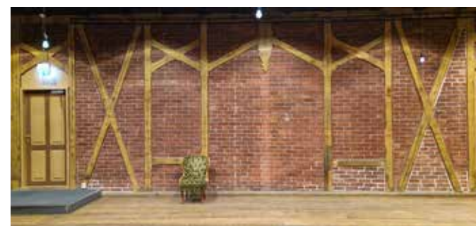
Sangsalens indre i dag. Etter restaureringen tidlig på 2000-tallet er den dekorativt utformede, utmurt bindingsverkkonstruksjonen synlig igjen. Foto: Hanne Windholt.
